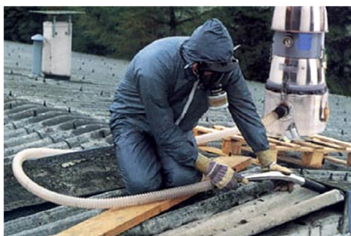
Zdjęcie 17 Przykład prawidłowego postępowania przy demontażu pokrycia dachowego z eternitu, pracownik ubrany w pyłoszczelny kombinezon z maską posługuje się specjalistycznym odkurzaczem z filtrem HEPA.
