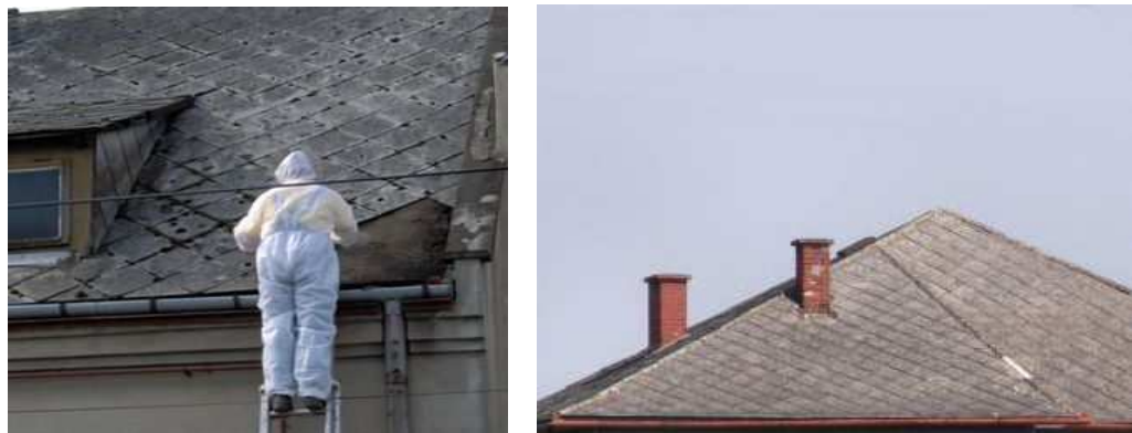
Zdjęcie 7 Płyty płaskie prasowane tzw. szablony lub płyty „karo” (PN-66/B-14040)
