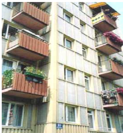
Zdjęcie 10 Elewacja wykonana z płyt azbestowo-cementowych płaskich
