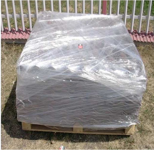
Zdjęcie 19 Prawidłowo przygotowane do transportu zdemontowane płyty azbestowo-cementowe.
