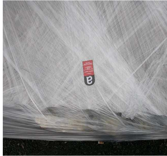
Zdjęcie 19 Prawidłowo przygotowane do transportu zdemontowane płyty azbestowo-cementowe.
