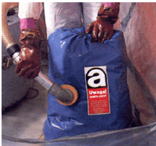
Zdjęcie 17 Przykład prawidłowego postępowania przy demontażu pokrycia dachowego z eternitu, pracownik ubrany w pyłoszczelny kombinezon z maską posługuje się specjalistycznym odkurzaczem z filtrem HEPA.
