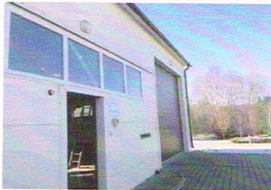
Budynek hala mechanicznego podczyszczania
