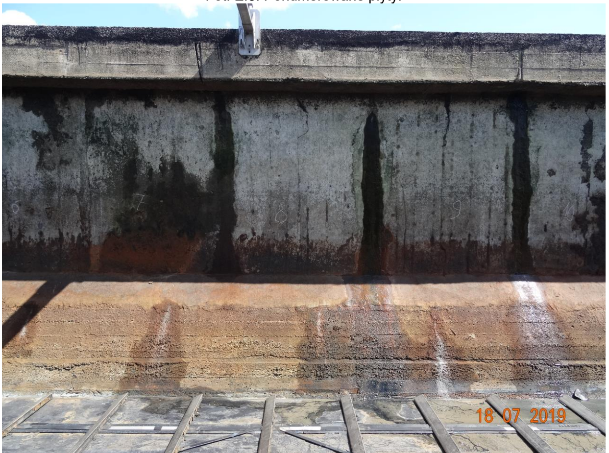
Fot. E.4. Najsłabsza płyta nr 7. Przecieki na zamkach płyt.
