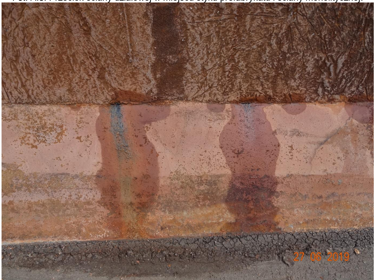
Fot. A.6. Nieliczne przecieki ściany działowej.
