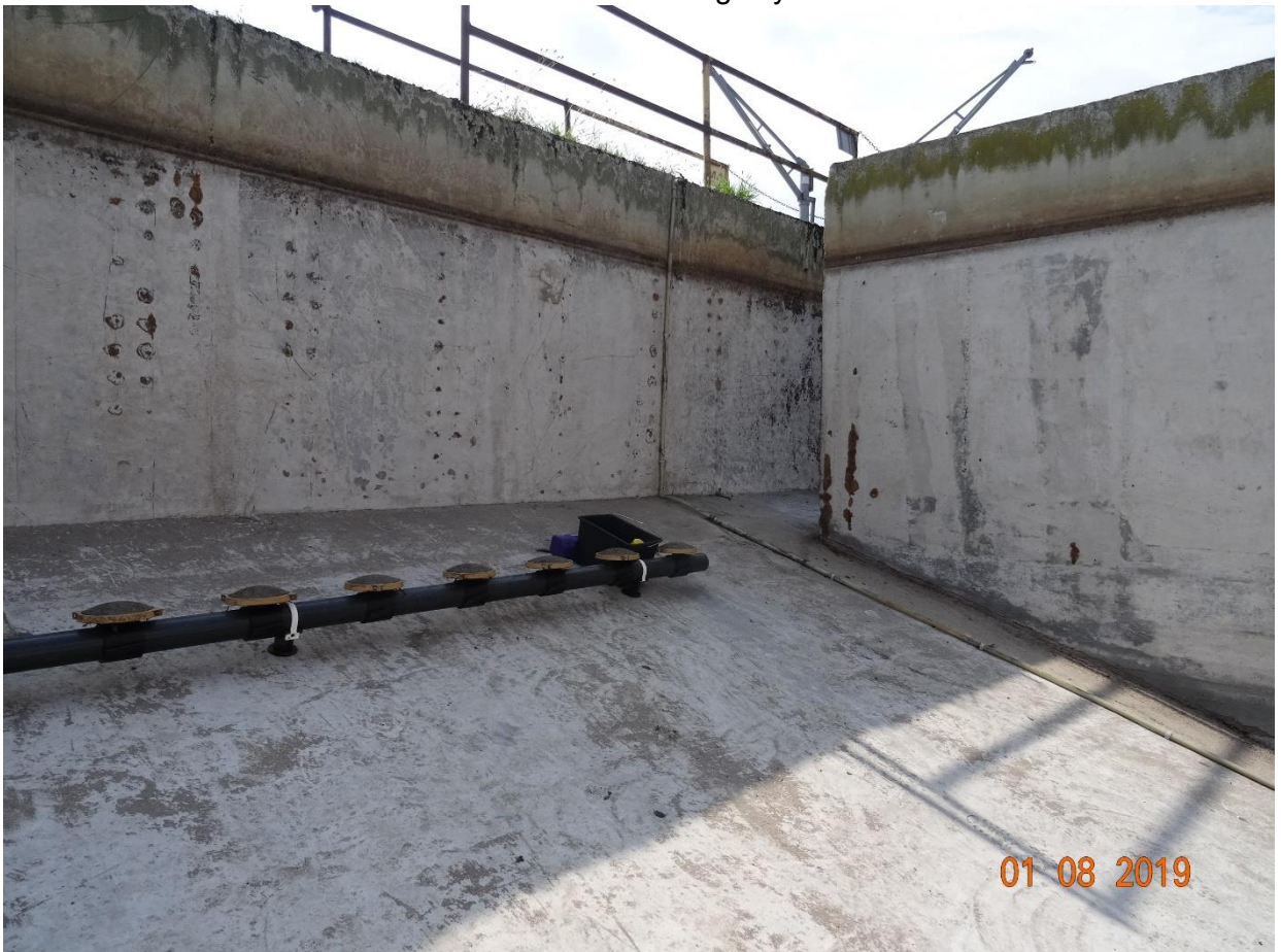
Fot. D.2. Punktowe ślady korozji.
