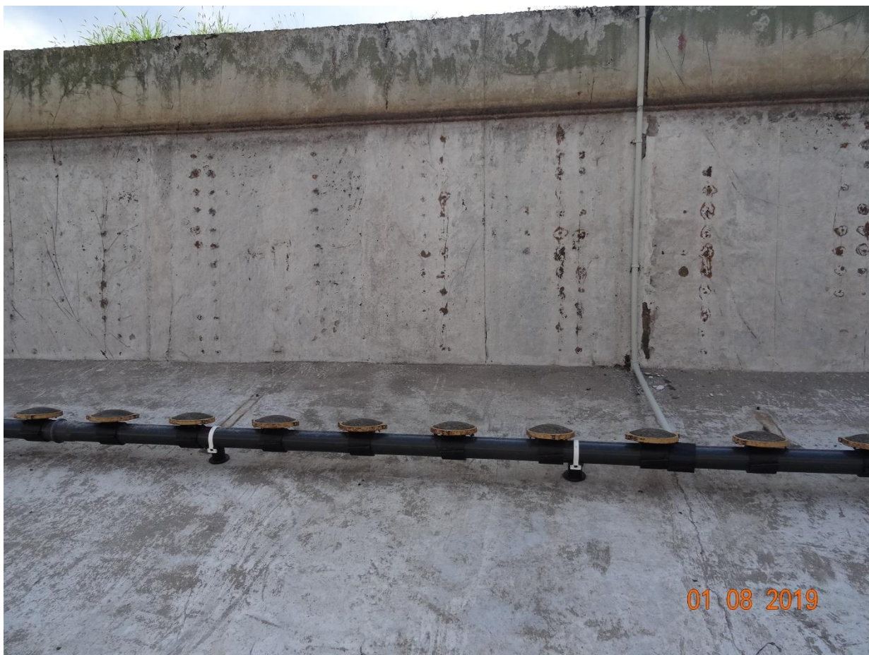
Fot. D.5. Punktowe ślady korozji zbrojenia ściany i pęknięcie dna.
