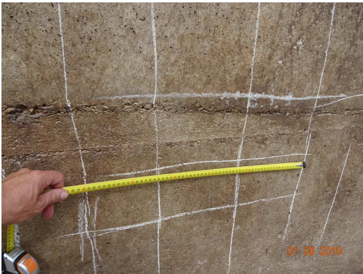
Fot. D.7. Namierzony rozkład zbrojenia.
