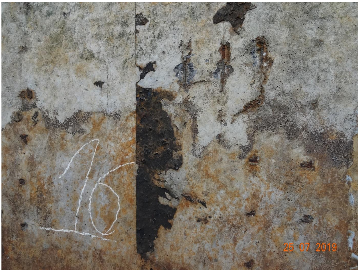
Fot. F.3. Widoczne skorodowane zbrojenie.
