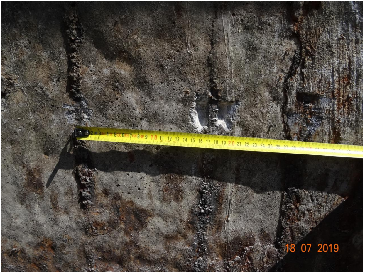
Fot. E.5. Rozstaw zbrojenia. Zbyt mała otulina.
