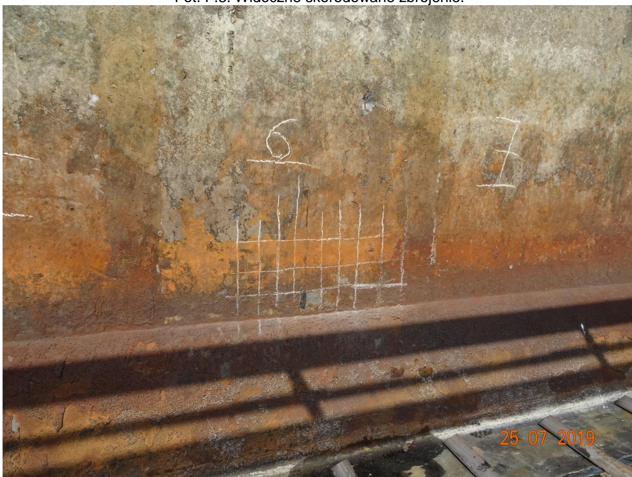
Fot. F.4. Miejsce wybrane do wykonania odwiertu.
