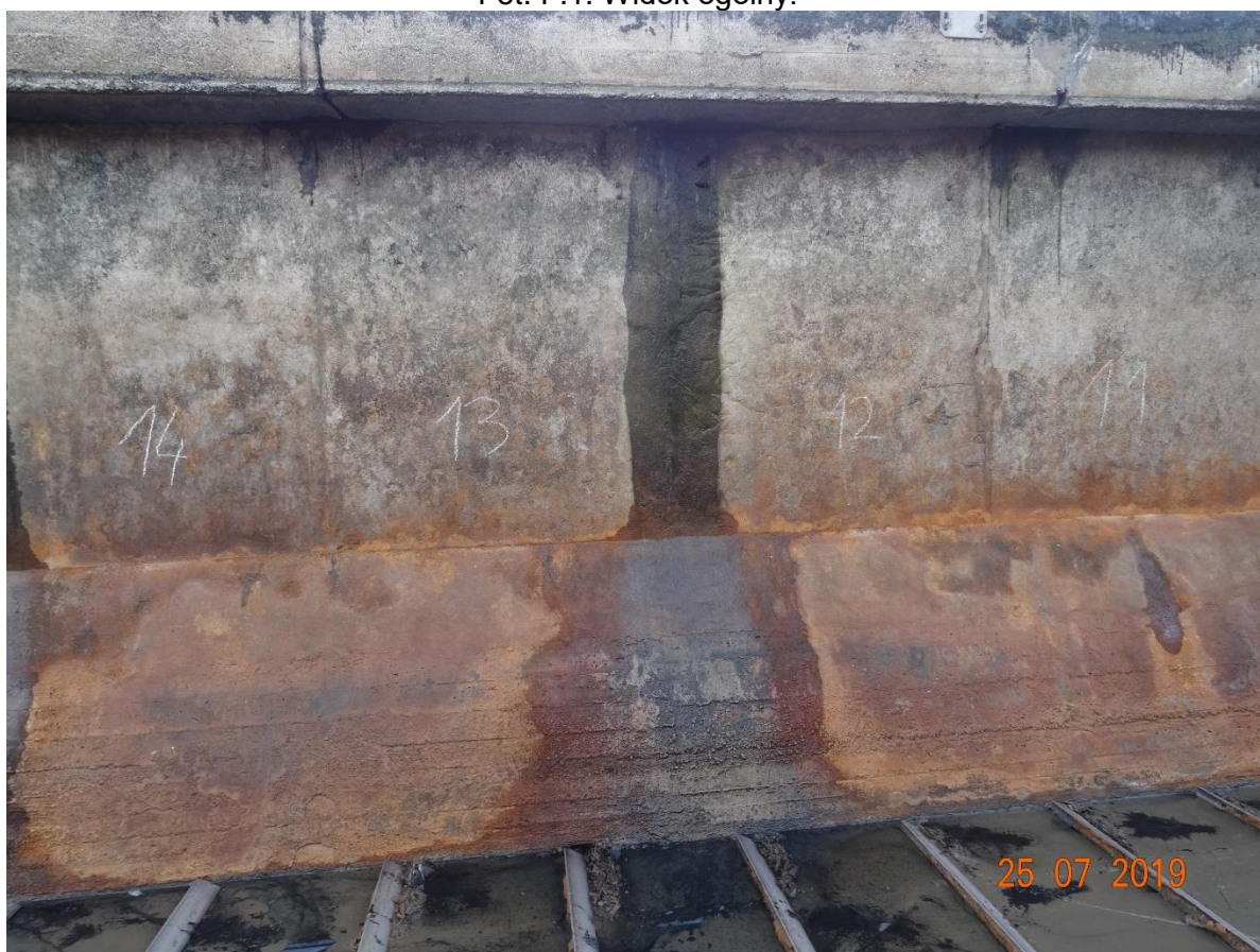
Fot. F.2. Tu dość silnie przelewają się ścieki pod wieńcem.
