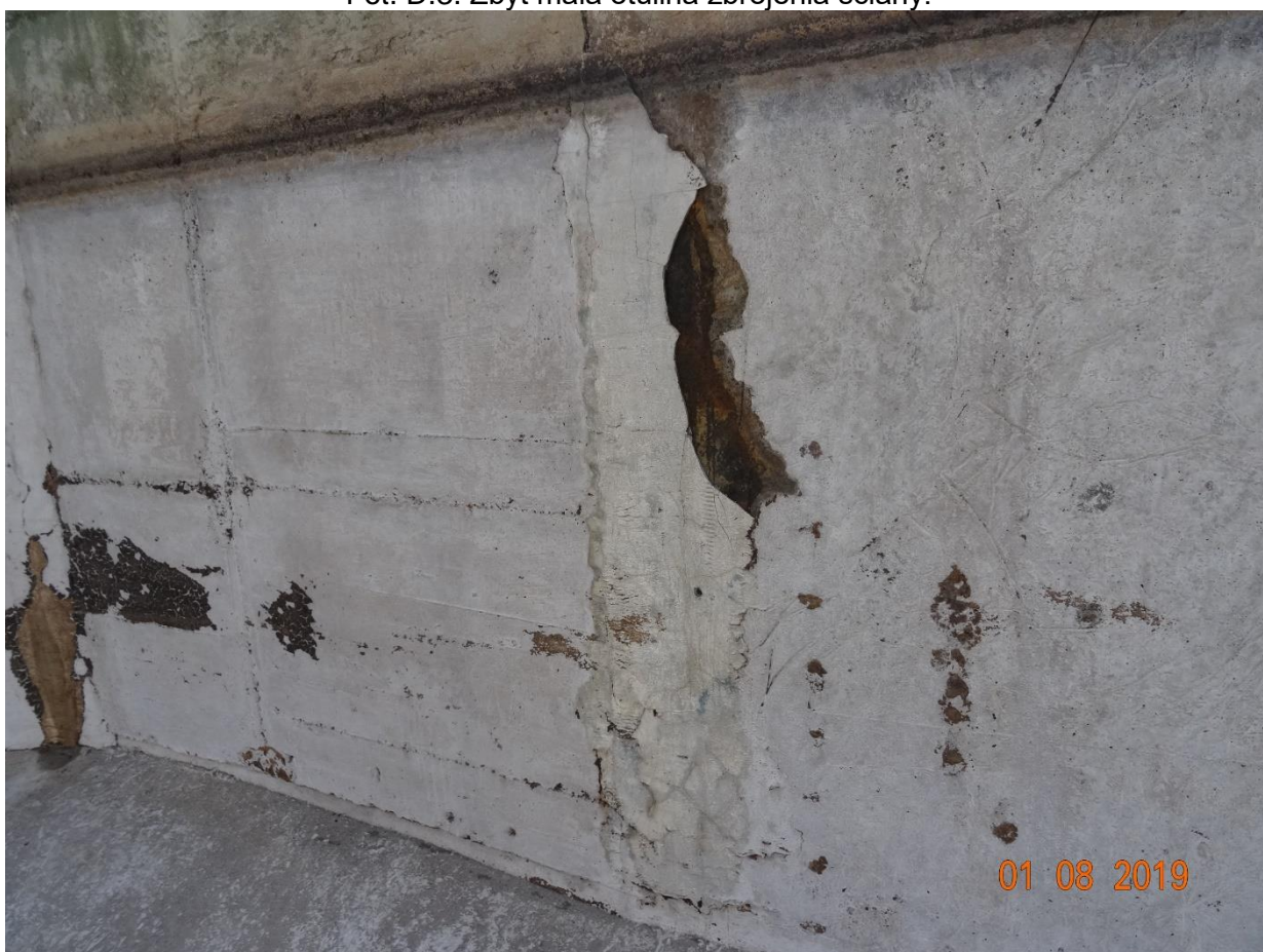
Fot. D.4. Styk płyty prefabrykowanej i betonu lanego. Wcześniej naprawiany przeciek.
