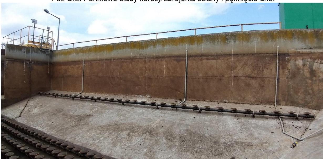
Fot. D.6. Kredą zaznaczono rysy 0,1 mm na ścianie.
