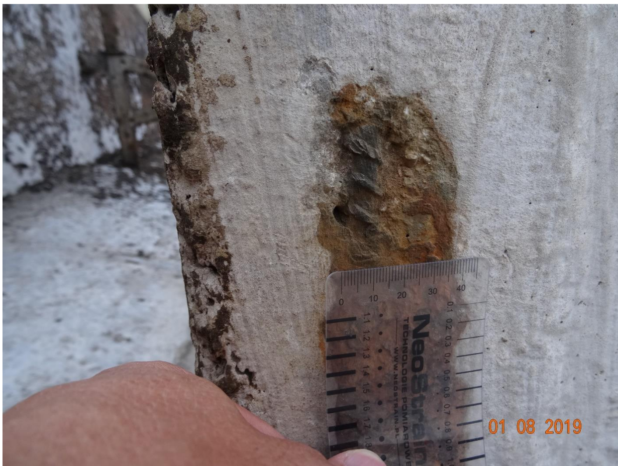
Fot. D.3. Zbyt mała otulina zbrojenia ściany.
