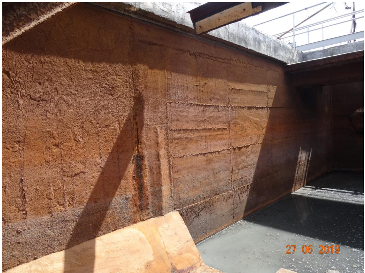
Fot. A.5. Przeciek ściany działowej w miejscu styku prefabrykatu i ściany monolitycznej.
