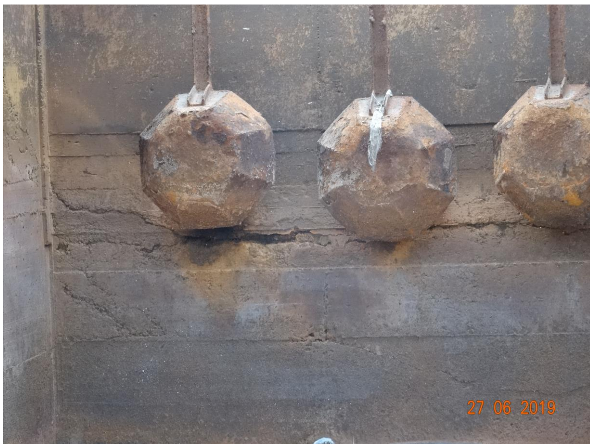
Fot. A.3. Raki w betonie w miejscu przerwy technologicznej.
