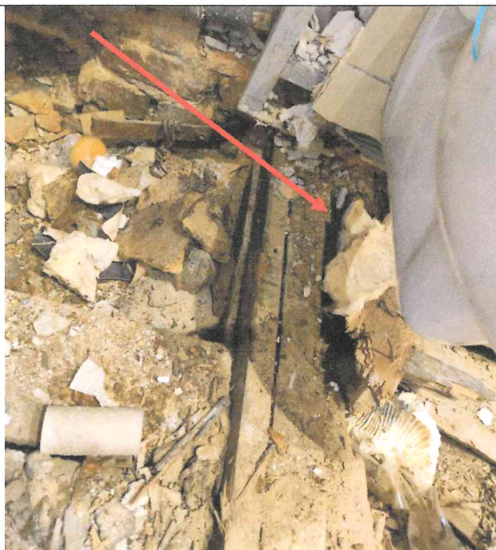
Fot. 2- Zbutwiałe końcówki belek drewnianych
