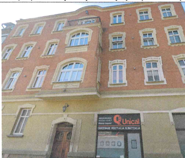
Fot. 1- Budynek przy ul. Katowickiej 13-elewacja frontowa
