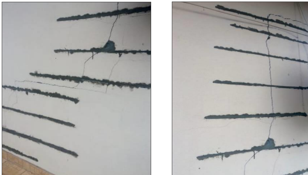
Rys. 28 Zszycie rys zbrojeniem – ściana wewnętrzna
