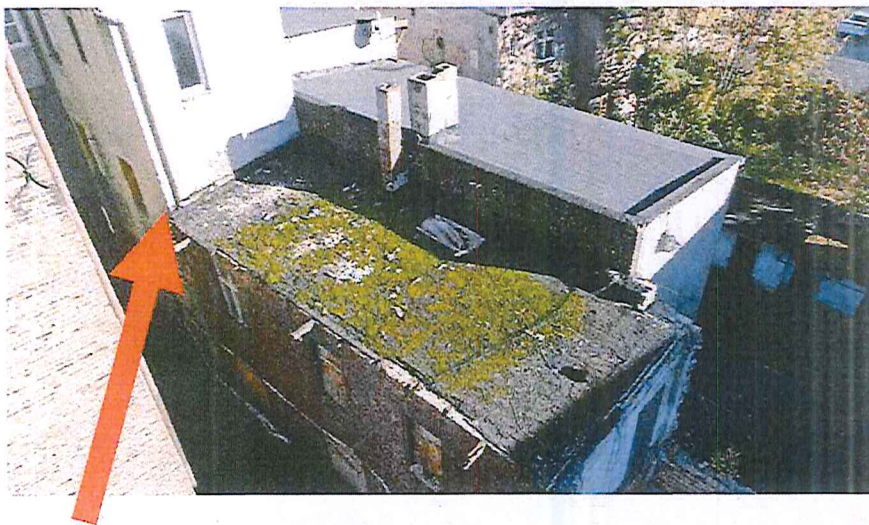
Odprowadzenie wody z wyższej części dachu na niższą
