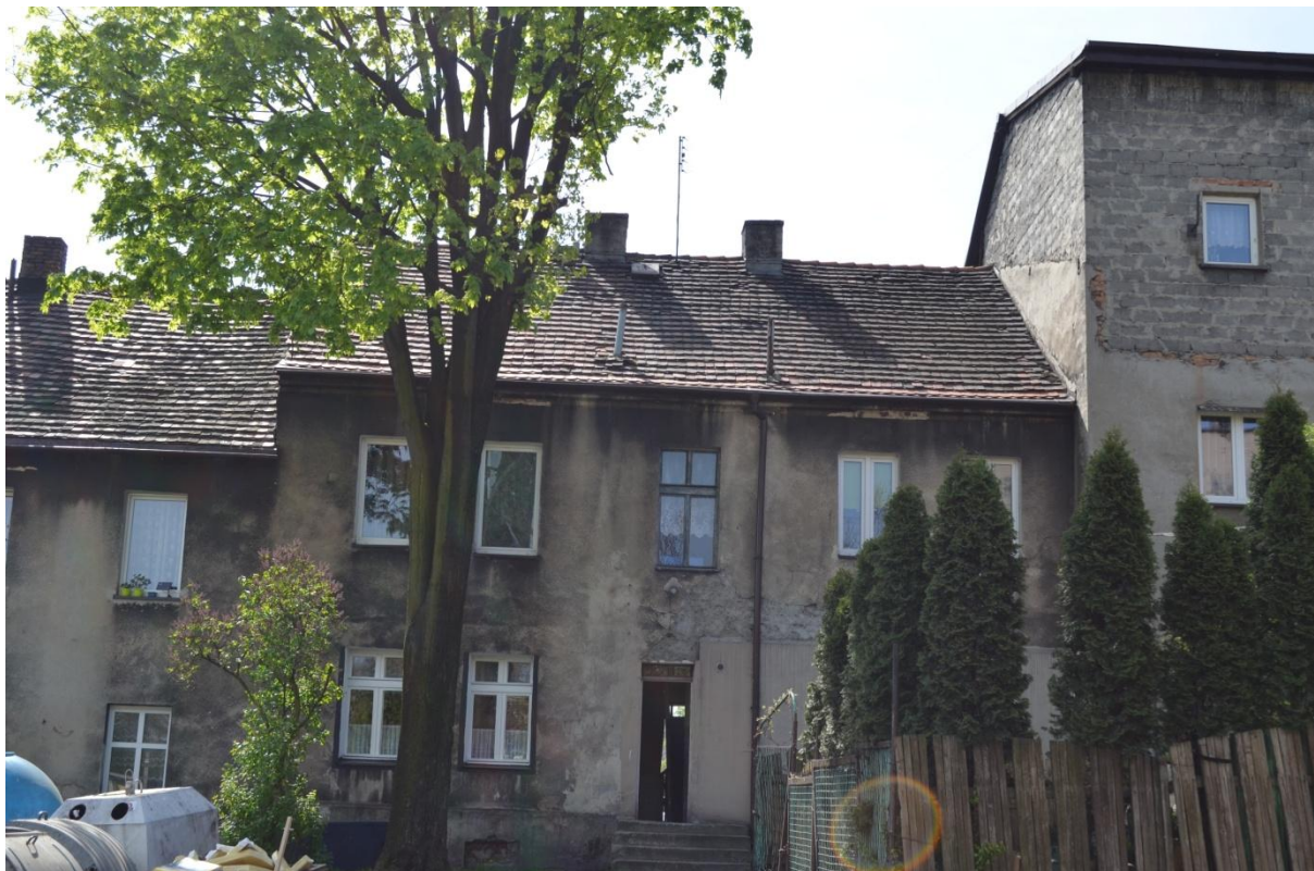
Zdjęcie nr 3 – Elewacja tylna - dach z dachówki karpiówki
