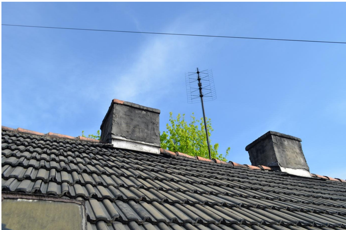
Zdjęcie nr 5 – Widok połaci dachowej - dachówka zakładkowa, kominy spalinowe
