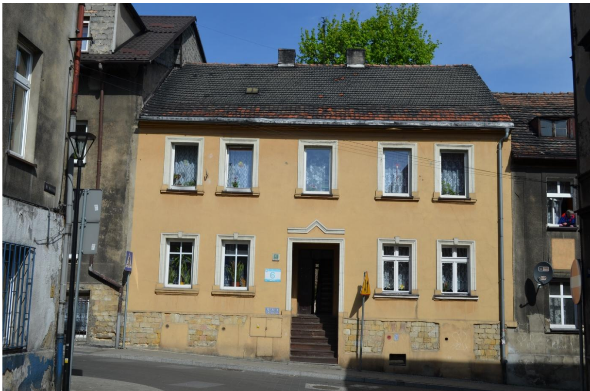
Zdjęcie nr 2 – Elewacja frontowa - dach z dachówki karpiówki i dachówki zakładkowej
