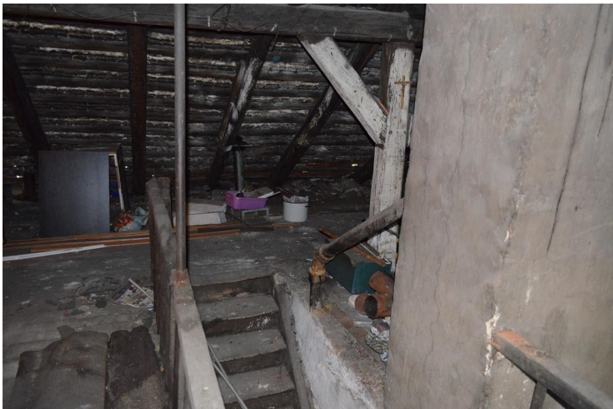
Zdjęcie nr 8 – Schody prowadzące na poddasze, widoczna rura wywiewna kanalizacji
