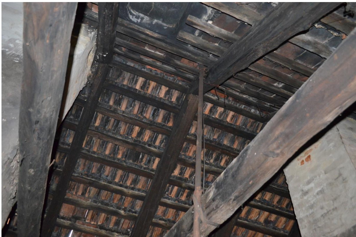
Zdjęcie nr 14 – Widok ogólny na konstrukcję dachu - krokwie i jętki
