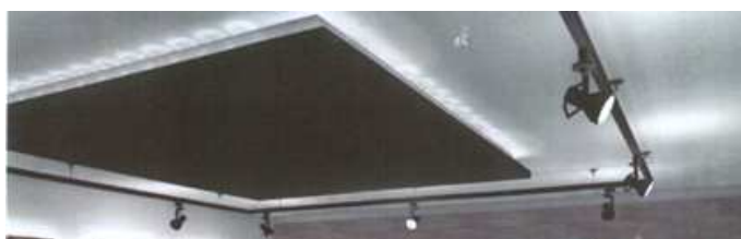
sufit w pomieszczeniu "sale ekspozycyjna"
