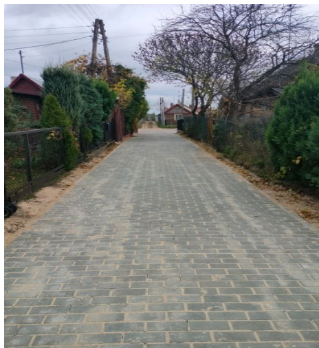
Przebudowa ul. Kasztanowej w Hajnówce Wartość inwestycji: 70 024,80 zł
