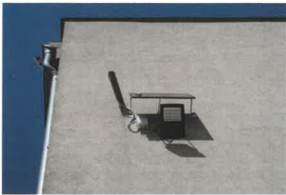
Oświetlenie zewnętrzne – lampy hybrydowe typu LED z panelem solarnym
