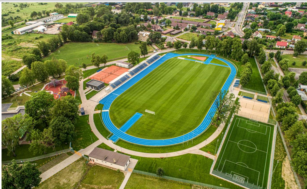
Rys. 13 Ośrodek Sportu i Rekreacji w Hajnówce (źródło: https://panoramaos.pl/realizacje/gmina-miejska-hajnowka/ )
