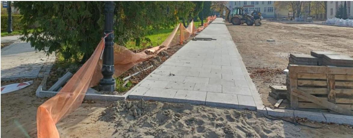
Chodnik od strony skwerku im. Dymitra Wasilewskiego - w budowie
