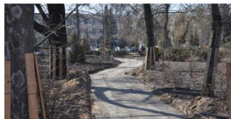
Prace rewitalizacyjne na skwerze im. D. Wasilewskiego
