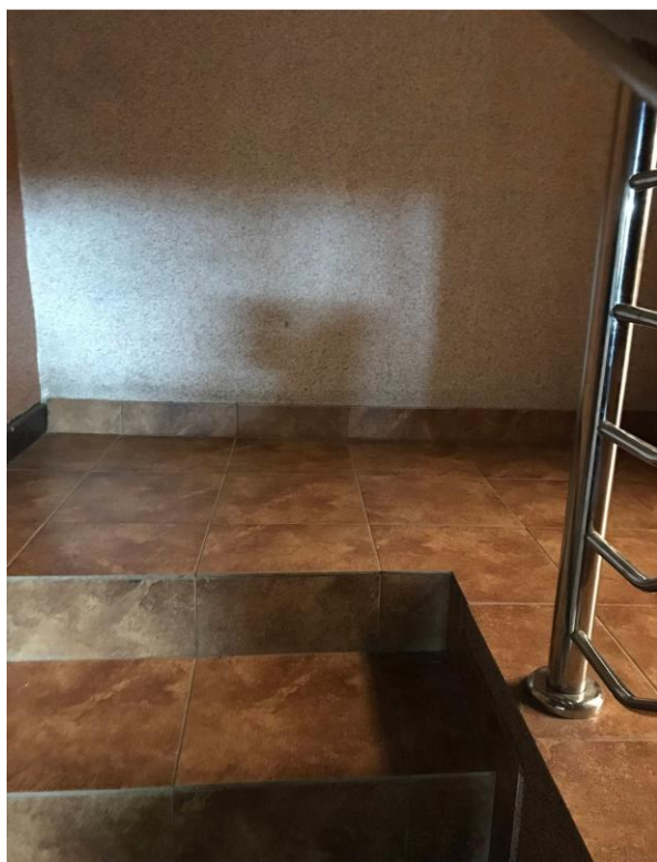
Fot. 8 (po lewej). Balustrada nieodzwierciedlająca biegu schodowego.
