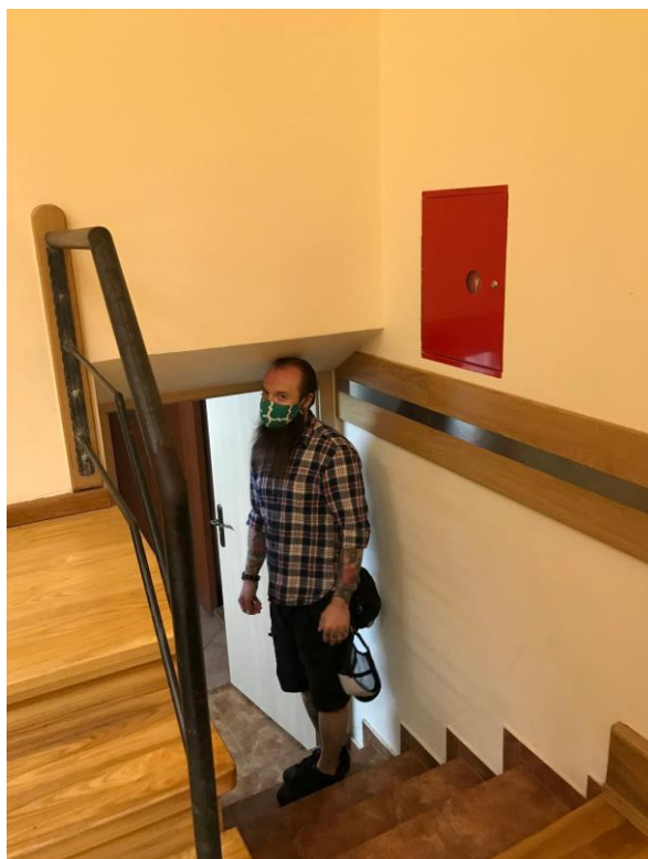
Fot. 8 (po lewej). Balustrada nieodzwierciedlająca biegu schodowego.
