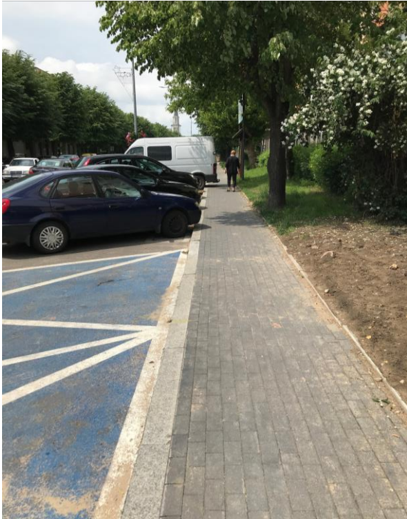
Fot. 1 (po lewej). Dojście z ryzykiem nawisu samochodów.
