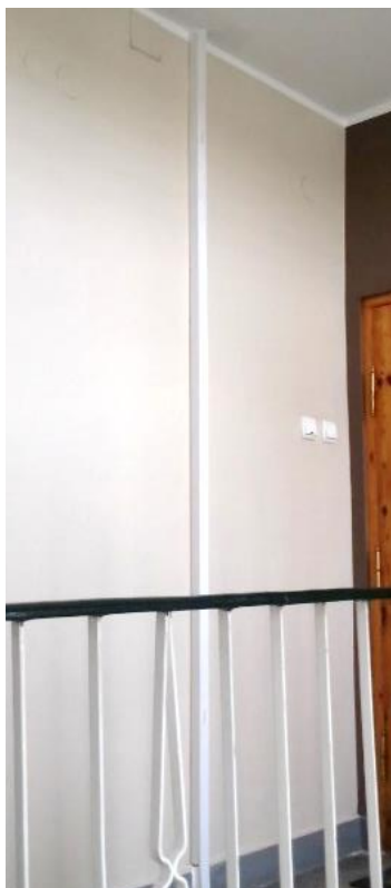
Rysunek 3 – Przykładowe sposoby wykonania nowej trasy infrastruktury pionowej:
