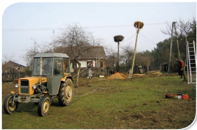
Ustawianie słupa przy pomocy traktora. Fot. AT
