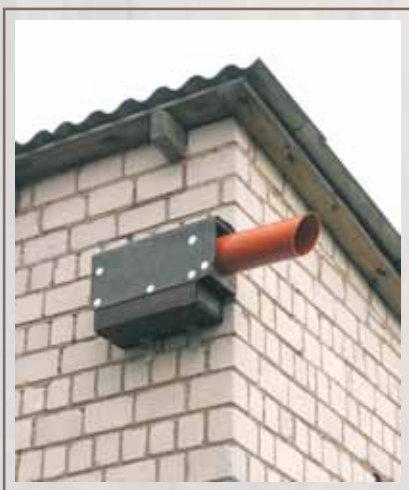
Skrzynka dla pójdzki zabezpieczona przed kuną. Fot. AT
