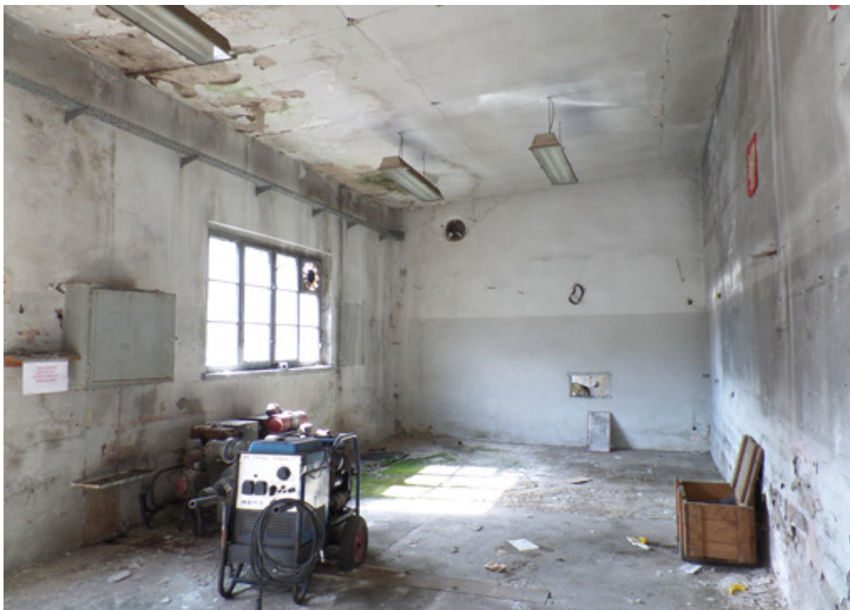
Fot. Nr 8a – wnętrze parteru części jednokondygnacyjnej budynku z dachem drewnianym
