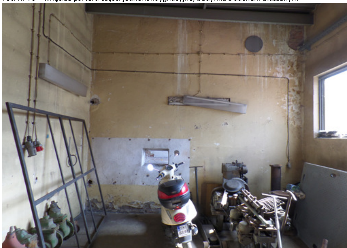
Fot. Nr 7b – wnętrze parteru części jednokondygnacyjnej budynku z dachem blaszanym
