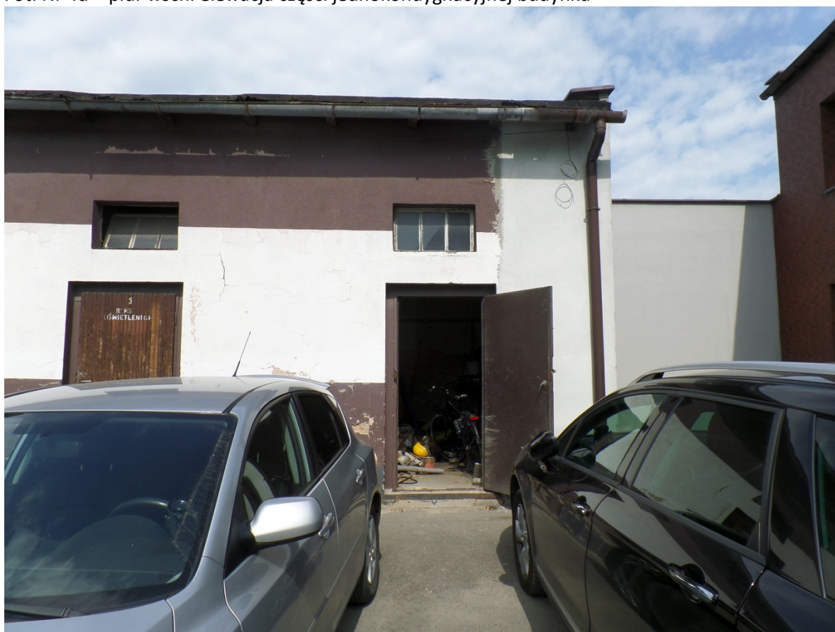
Fot. Nr 4e – płd.-wsch. elewacja części jednokondygnacyjnej budynku
