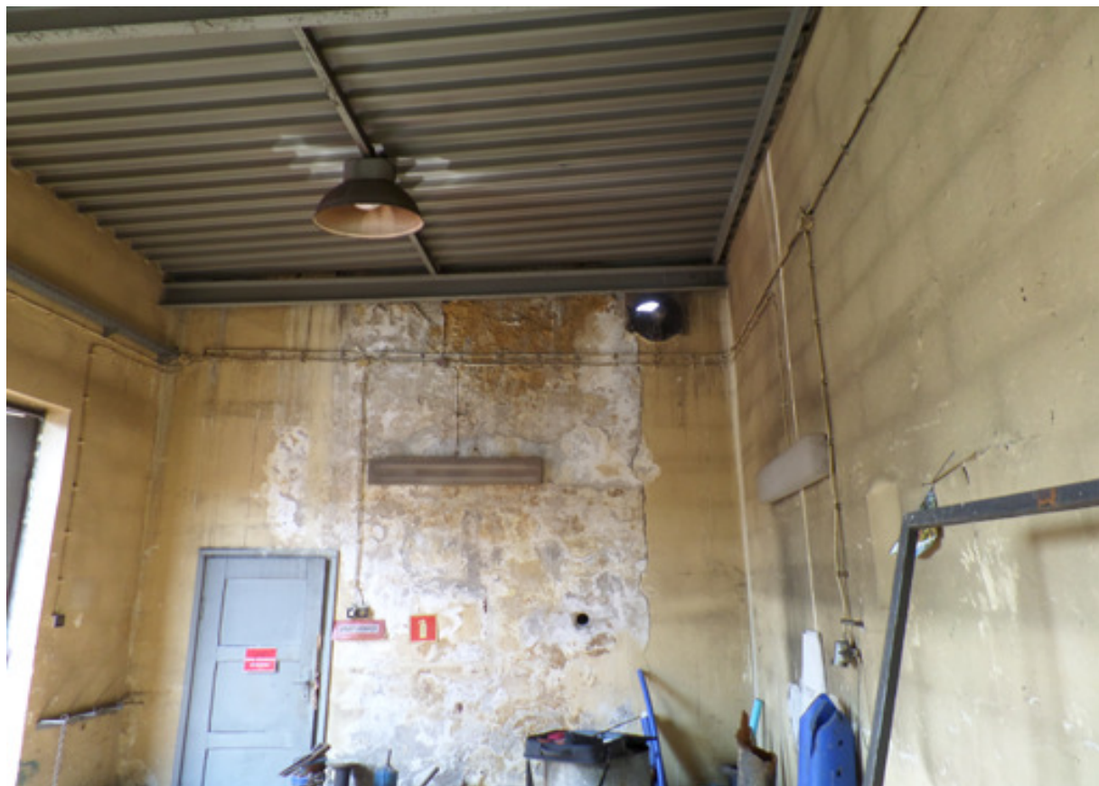
Fot. Nr 7a – wnętrze parteru części jednokondygnacyjnej budynku z dachem blaszanym
