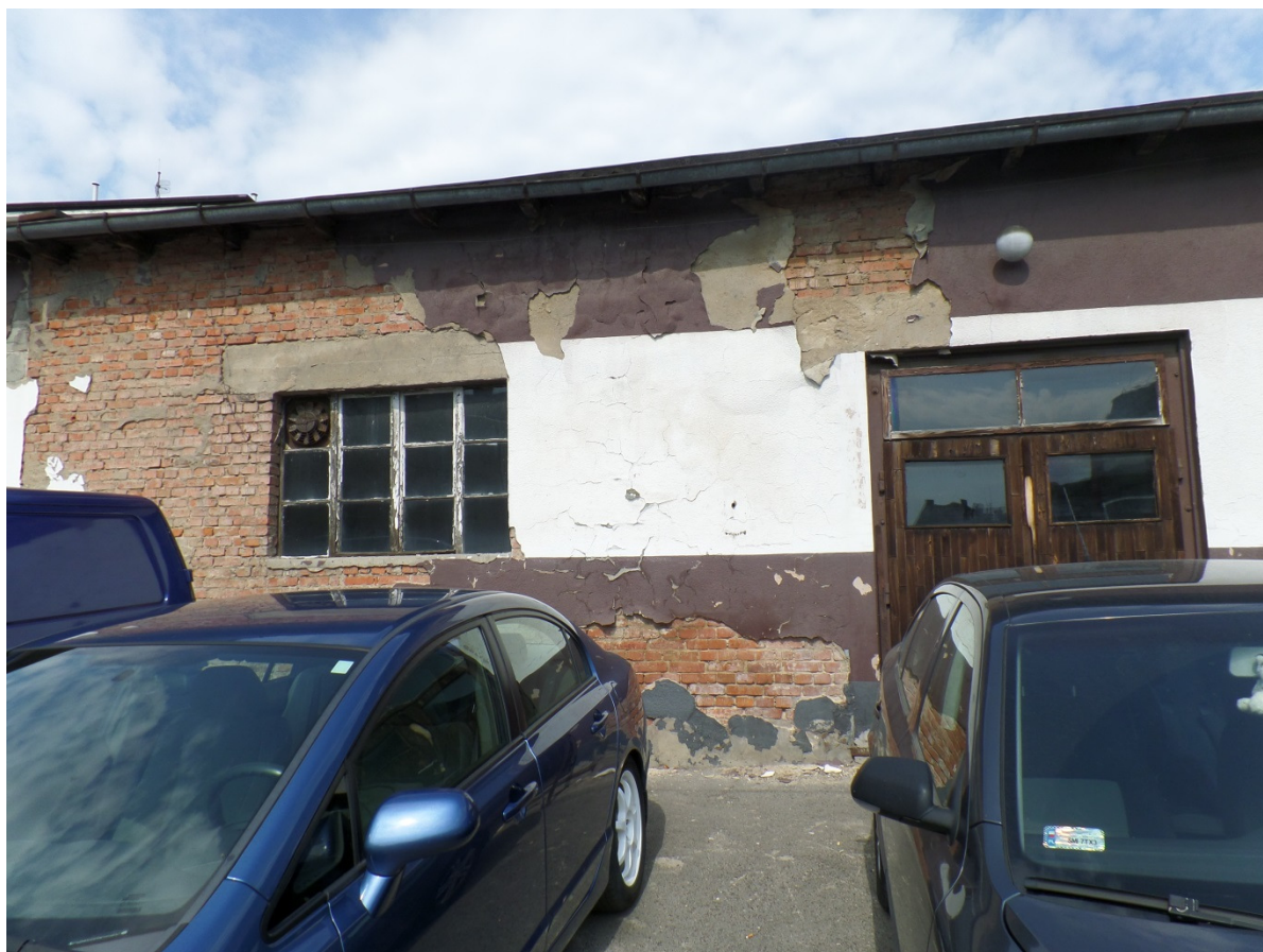
Fot. Nr 4b – płd.-wsch. elewacja części jednokondygnacyjnej budynku
