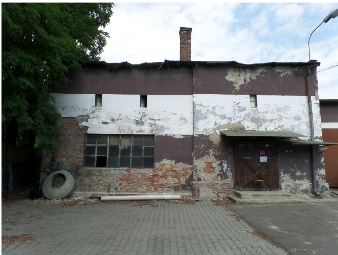
Fot. Nr 2 – płd.-zach. elewacja części dwukondygnacyjnej budynku
