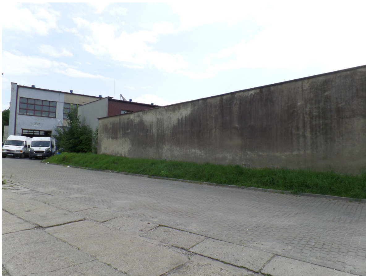
Fot. Nr 5a – płn.-zach. elewacja części jednokondygnacyjnej budynku
