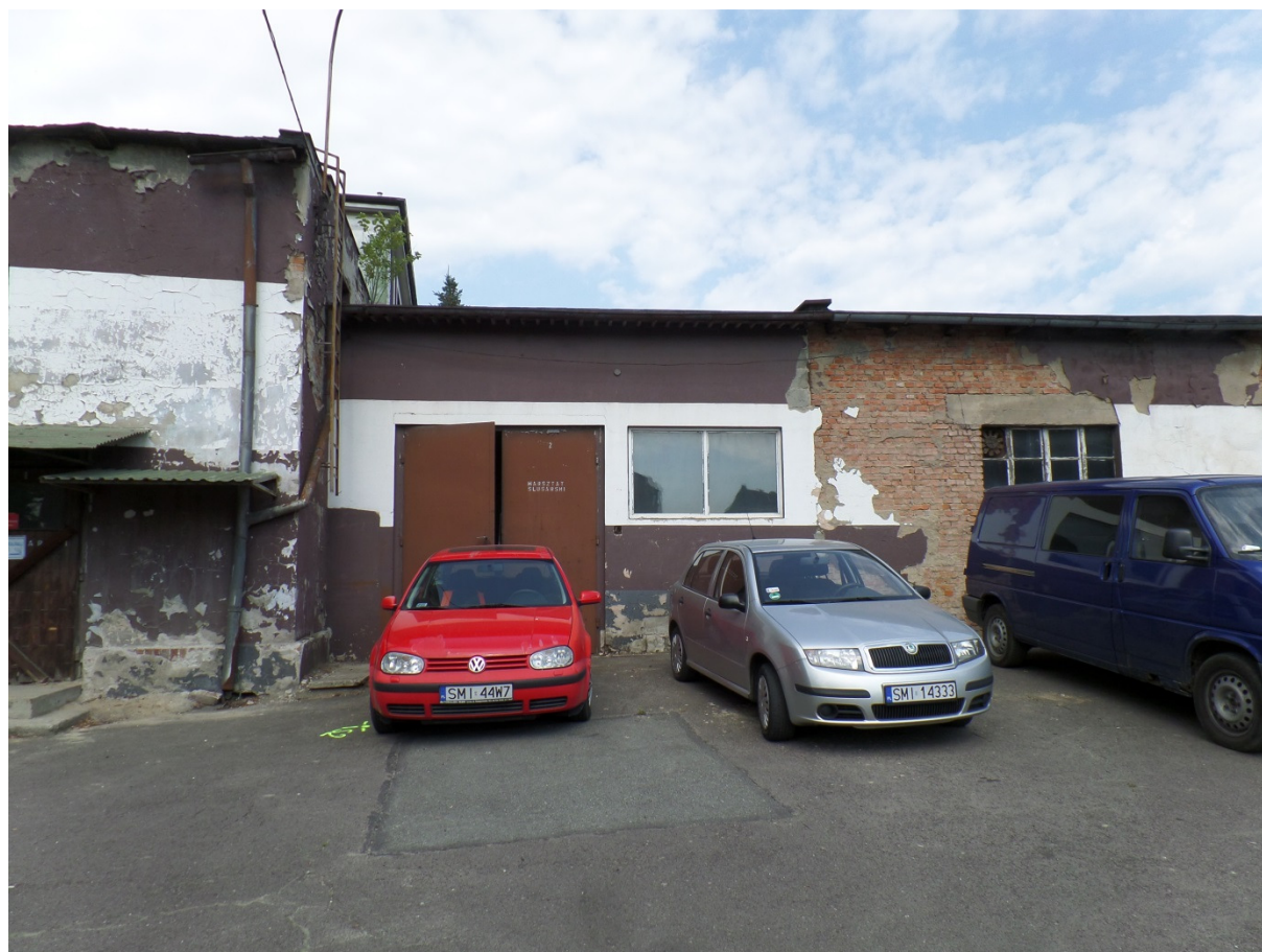
Fot. Nr 4a – półd.-wsch. elewacja części jednokondygnacyjnej budynku
