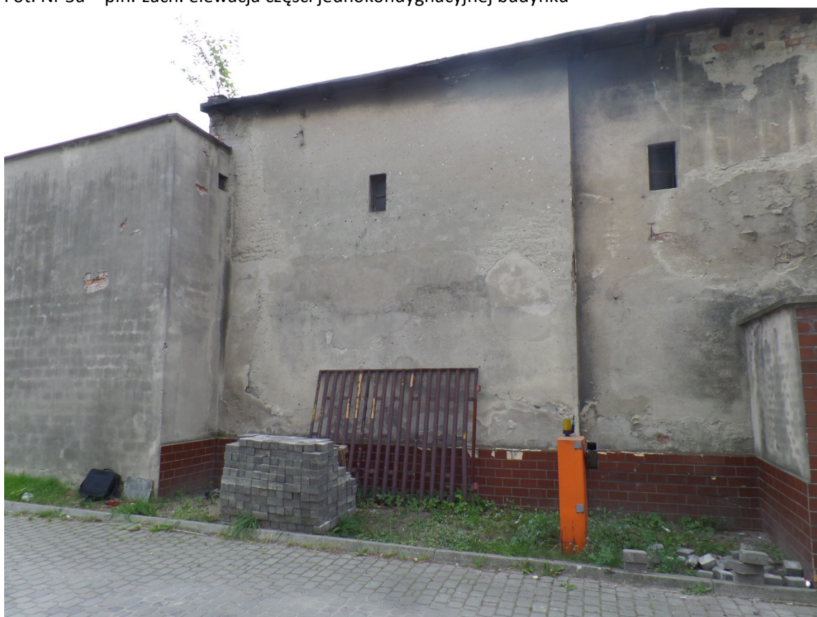
Fot. Nr 5b – płn.-zach. elewacja części jednokondygnacyjnej i dwukondygnacyjnej budynku
