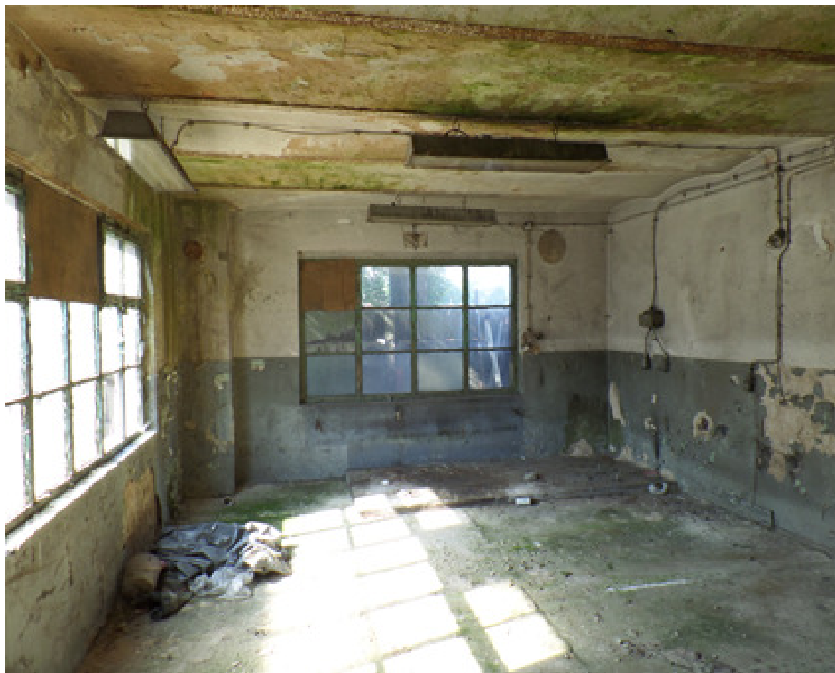
Fot. Nr 6a – wnętrze parteru części dwukondygnacyjnej budynku
