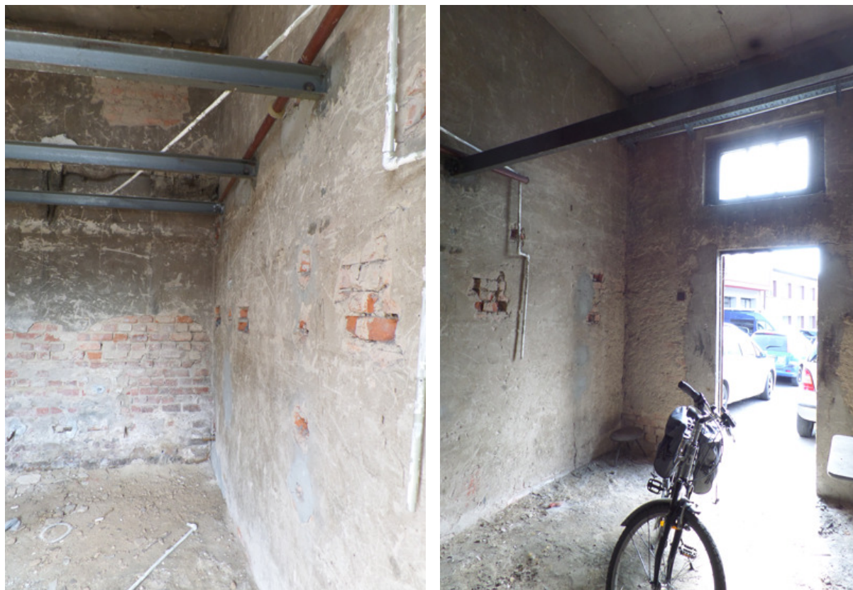
Fot. Nr 9a i 9b – wewnątrz parteru części jednokondygnacyjnej budynku z dachem drewnianym – wewnątrz jednego z trzech boksów magazynowych
