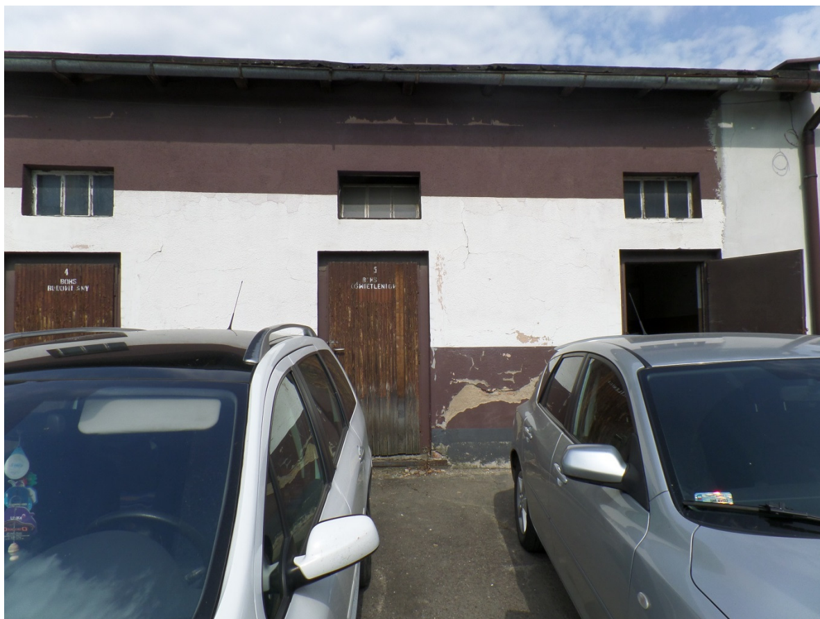
Fot. Nr 4d – płd.-wsch. elewacja części jednokondygnacyjnej budynku
