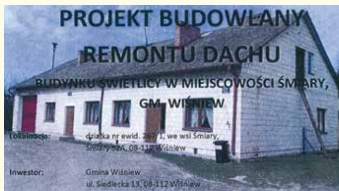
Dokumentacja projektowa. Fot. UG
