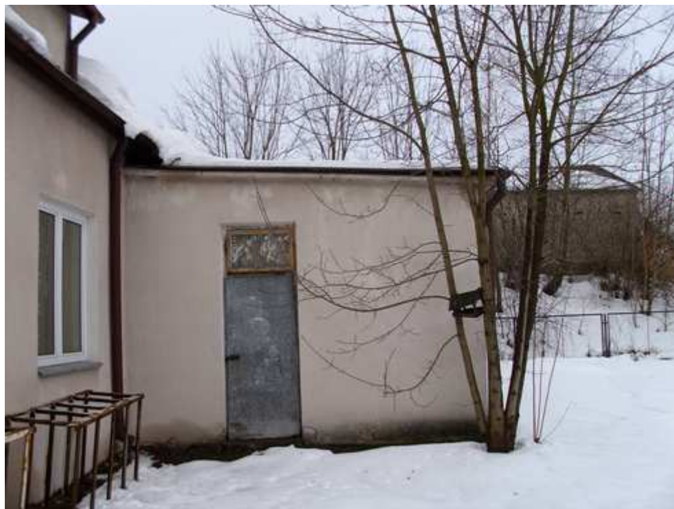
Fot.10 Elewacja wschodnia – pomieszczenie gospodarcze garażu wejście
