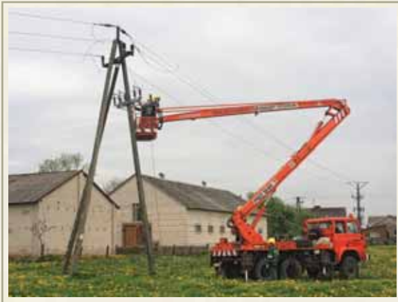
Instalacja nowego rozłącznika. Fot. IK
